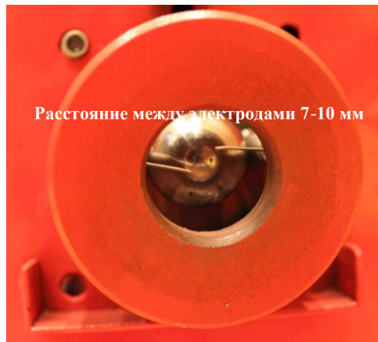
Установка электродов розжига на форсунках №2, №3
